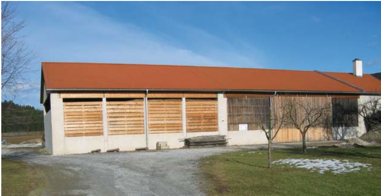
Abbildung 20: Biomasseheizwerk in Zwaring-Pöls (siehe Anhang 6.5)
