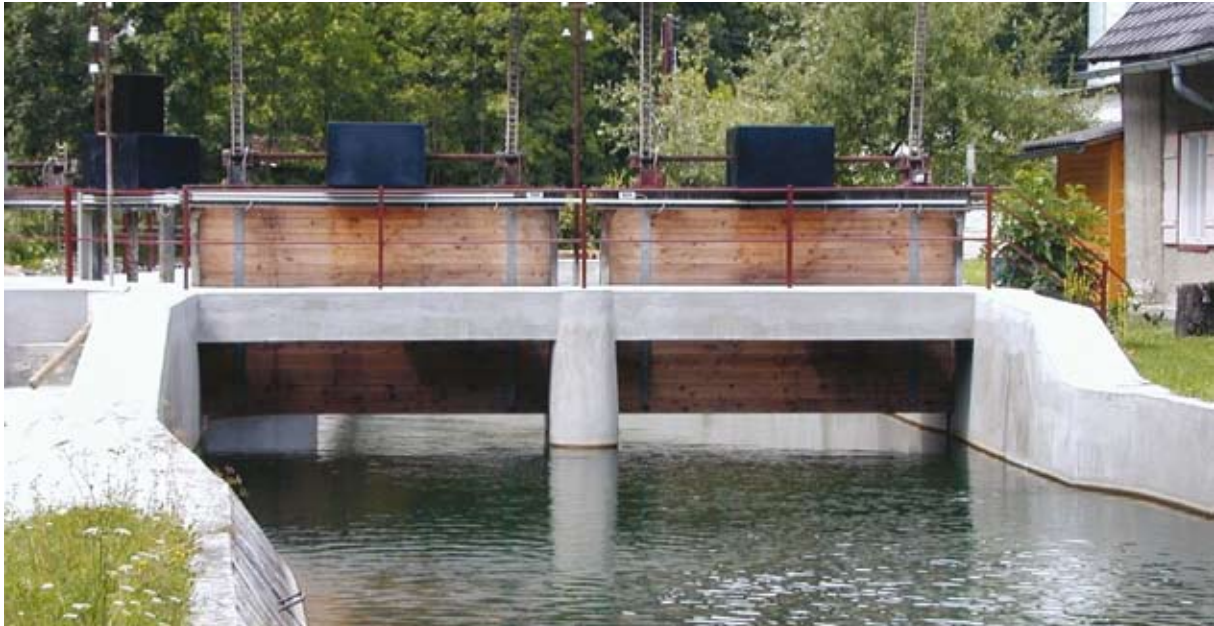
Abbildung 25: Wassererfassung Kohleben Quelle: Energieagentur Steiermark gGmbH
