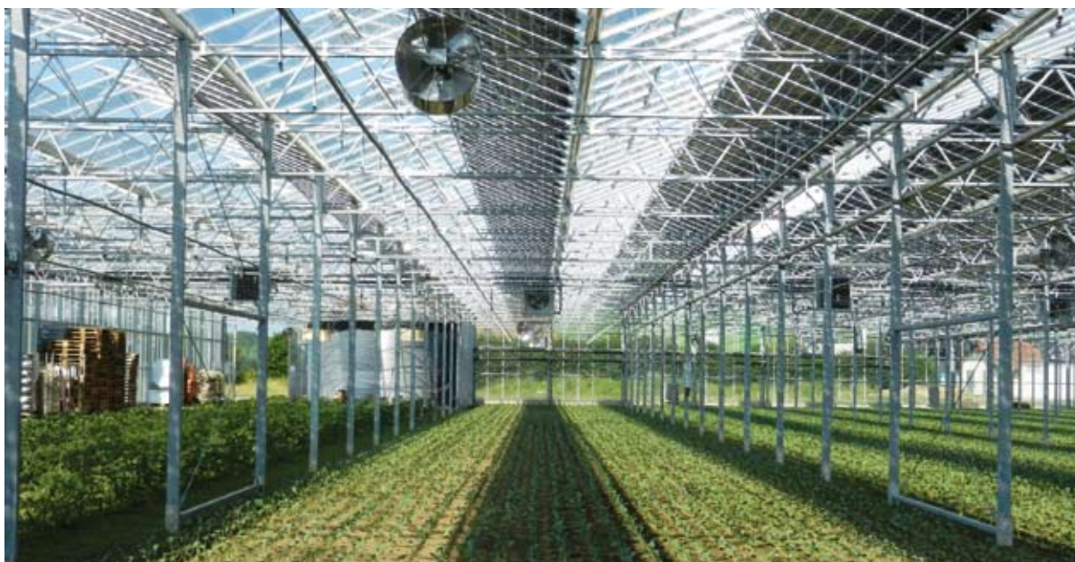
Abbildung 66: Gewächshaus Gartenbau Auer Quelle: SEBA Mureck
