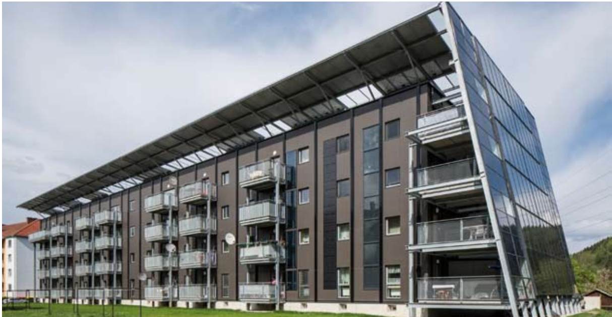
Abbildung 6: Sanierungsbeispiel Johann-Böhm-Strasse in Kapfenberg (siehe Anhang 6.1) Quelle: Gem. Wohn- u. Siedlungsgenossenschaft Ennstal reg. Gen.m.b.H. Liezen: Fotograf Walter Luttenberger
