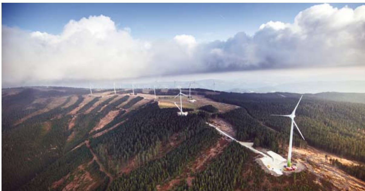
Abbildung 65: Windpark Steinriegel Quelle: Wien Energie, Fotograf: Ian Ehm
