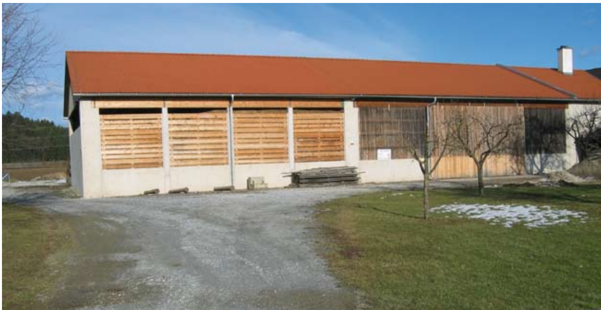
Abbildung 63: Heizwerk Zwaring Quelle: Nahwärme Zwaring Zach Ges.b.R.
