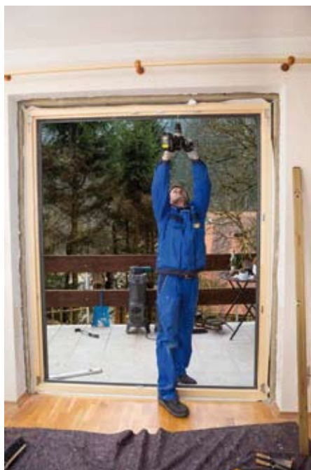
Abbildung 77: Fenstertausch bei Familie Unruh Quelle: Ich tu's Komfortsanierung – Land Steiermark, Copyright: Chris Zenz
