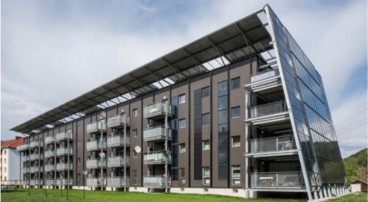
Abbildung 58: Johann-Böhm-Strasse nach der Sanierung zum Plusenergiegebäude
