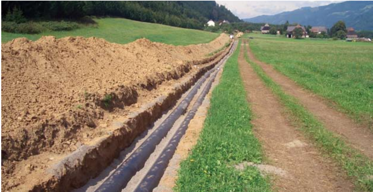
Abbildung 71: Fernwärmeleitungen der Bioenergie Aichfeld Quelle: Bioenergie Aichfeld GmbH
