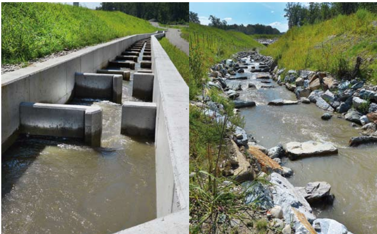
Abbildung 61: Fischaufstiegshilfen Kraftwerk Gössendorf Quelle: Energie Steiermark
