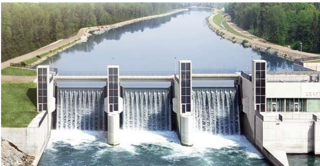
Abbildung 62: Laufwasserkraftwerk Gössendorf Quelle: Energie Steiermark
